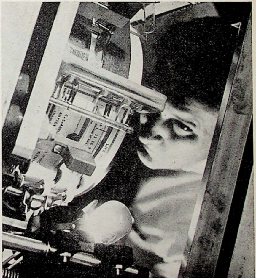
Optische leesinrichting van de IBM waarmee de informatie van gedrukte documenten rechtstreeks in het geheugen van een computer kan worden gelezen.
